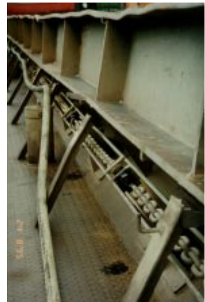
Abb. 1-18: Abgerissene Dennebaumstützen
